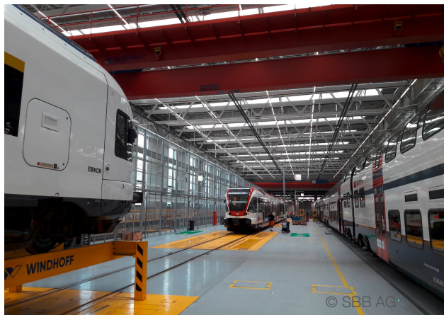
ABBILDUNG 1 | Blick in die moderne Instandhaltungshalle im SBB-Werk, Olten (Schweiz)
