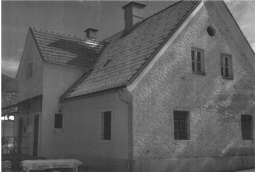
Abb. 1: Ehemaliges Entbindungsheim vor dem Abbruch im Jahr 2019
