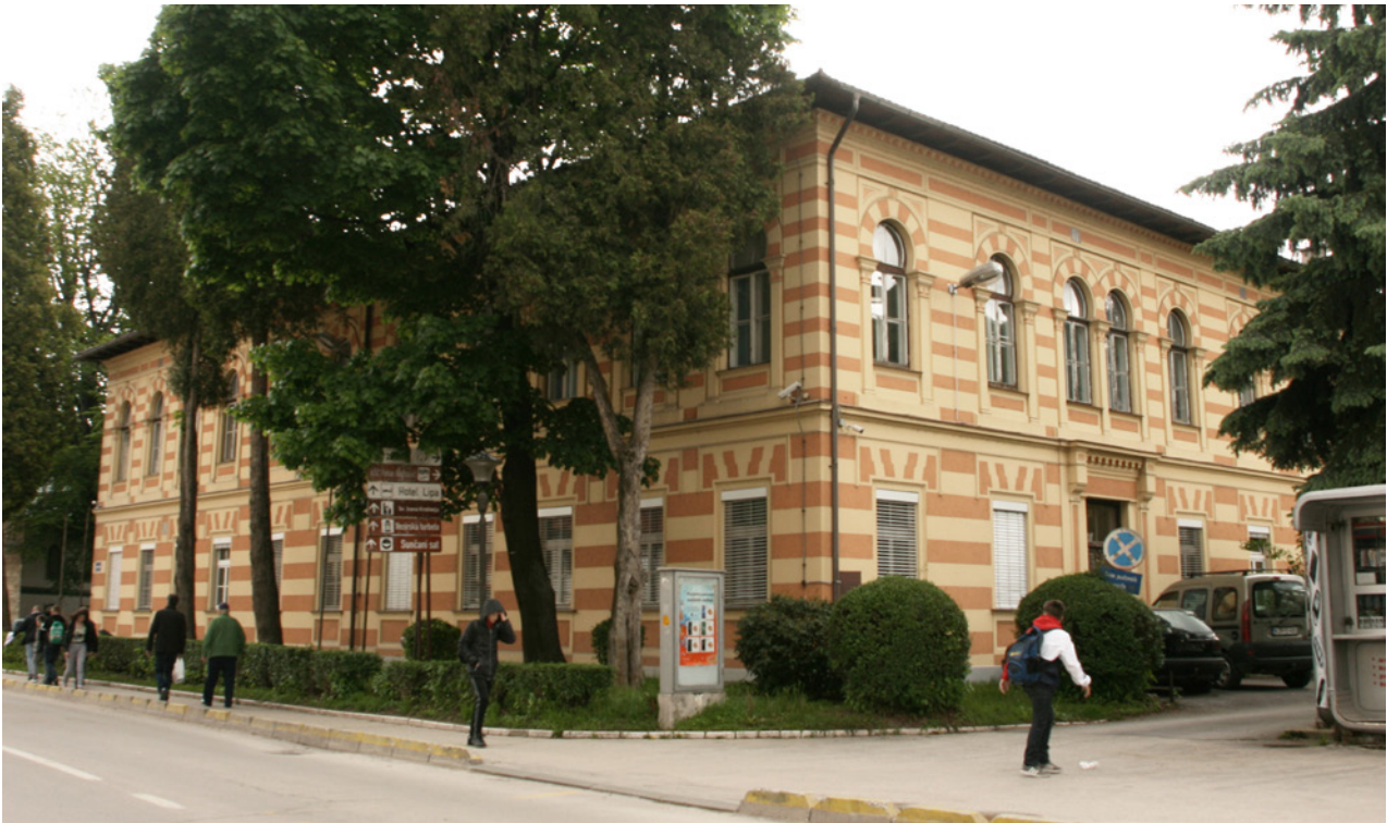
Abb. III.1.2.a. Travnik, ehem. Bezirksamt („Konak-Neubau“) von Nordwesten, errichtet 1892 mit späteren Erweiterungen. Foto: Jäger-Klein, 2019.
