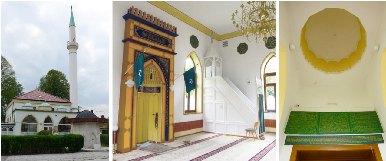
Abb. III.5.13.a-c. Visoko, Šadravska bzw. Alaudinova-Moschee, 1913-15 neu errichtet, Ansicht von Norden, Mihrab und zentrales Portikusjoch. Fotos: Hartmuth 2022.
