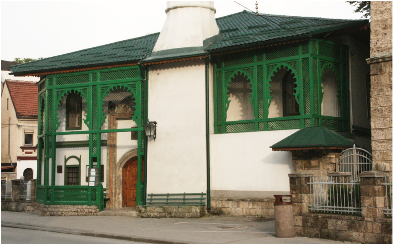
Abb. III.1.3 Travnik, Hadži Ali-begova Moschee (von Westen), Detail mit hölzerner Vorhalle von ca. 1892 in nichtoriginaler Farbgebung. Foto: Jäger-Klein 2021.
