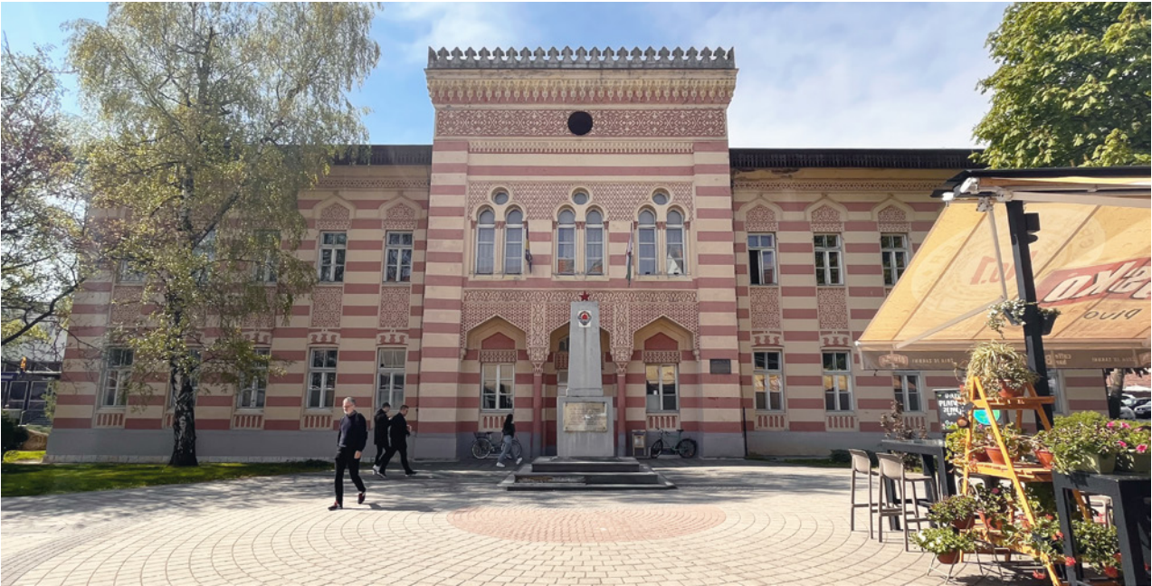
Abb. III.5.6.a. Bugojno, ehemaliges Rathaus, heute Gymnasium, 1901. Foto: Jäger-Klein 2022.
